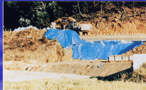
牟呂用水における 堤防崩壊事故 (H2.9.30 豊橋市)
